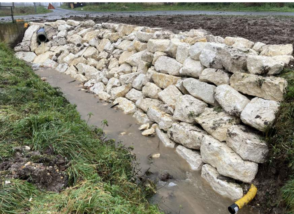
La berge après les travaux d'enrochement
